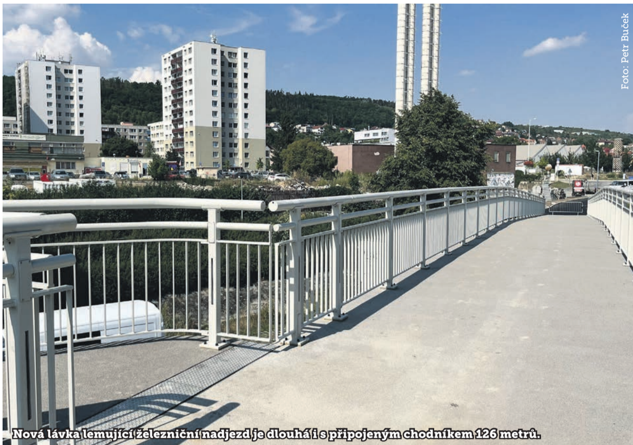
Obě lávky dostaly osvětlení umístěné v zábradlí.
